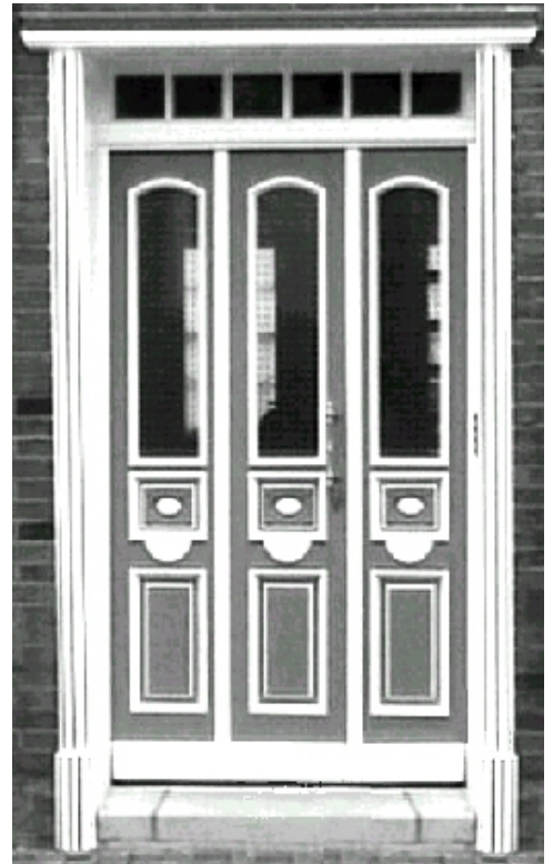
Die Haupttür der Waage wurde nach alten Vorbildern neugestaltet und die Neben- und Seitentüren entsprechend abgestimmt.
