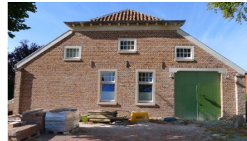
Das Gebäude macht derzeit bereits einen sehr guten Eindruck. Foto: G. Kronsweide
