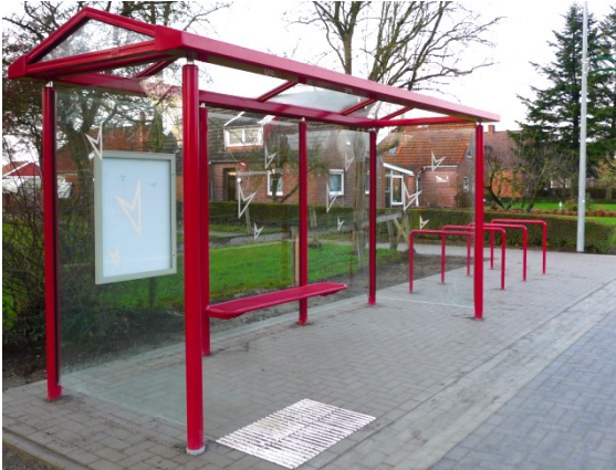
Die neue Bushaltestelle in Neu-Jemgum nach der Fertigstellung. Foto: G. Kronsweide
