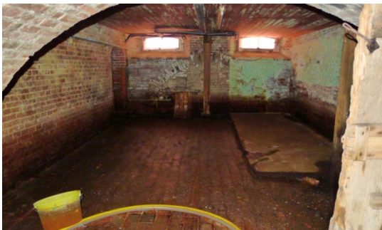
Blick in den mittleren Querkeller des alten Amtsgebäudes. Foto: G. Kronsweide
