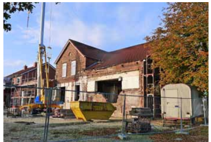
Die Baustelle auf der Gebäuderückseite (Süd) Foto: G. Kronsweide.
