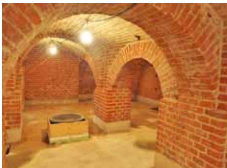
Blick in den betonierten hinteren Keller mit der provisorisch gesicherten Zisternenöffnung.
