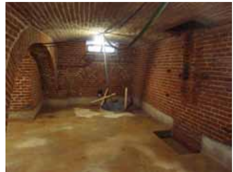
Der sanierte Raum im hinteren Keller mit dem Brunnenloch ohne und mit dem neuen Betonfußboden.
