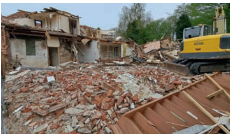
Der Bagger fraß sich von Westen nach Osten durch das Haus. Im Schutt: Steine im Klosterformat. Foto: H. Szyska RZ 29.4.2023.
